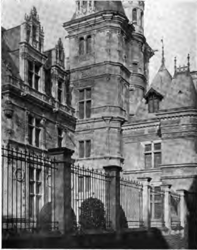
Fig. 106. — Escalier à vis à la rencontre des deux corps de logis de l'Hôtel Pincé à Angers. Prolongement de l'escalier par une tourelle portant sur encorbellement et sur trompe.
